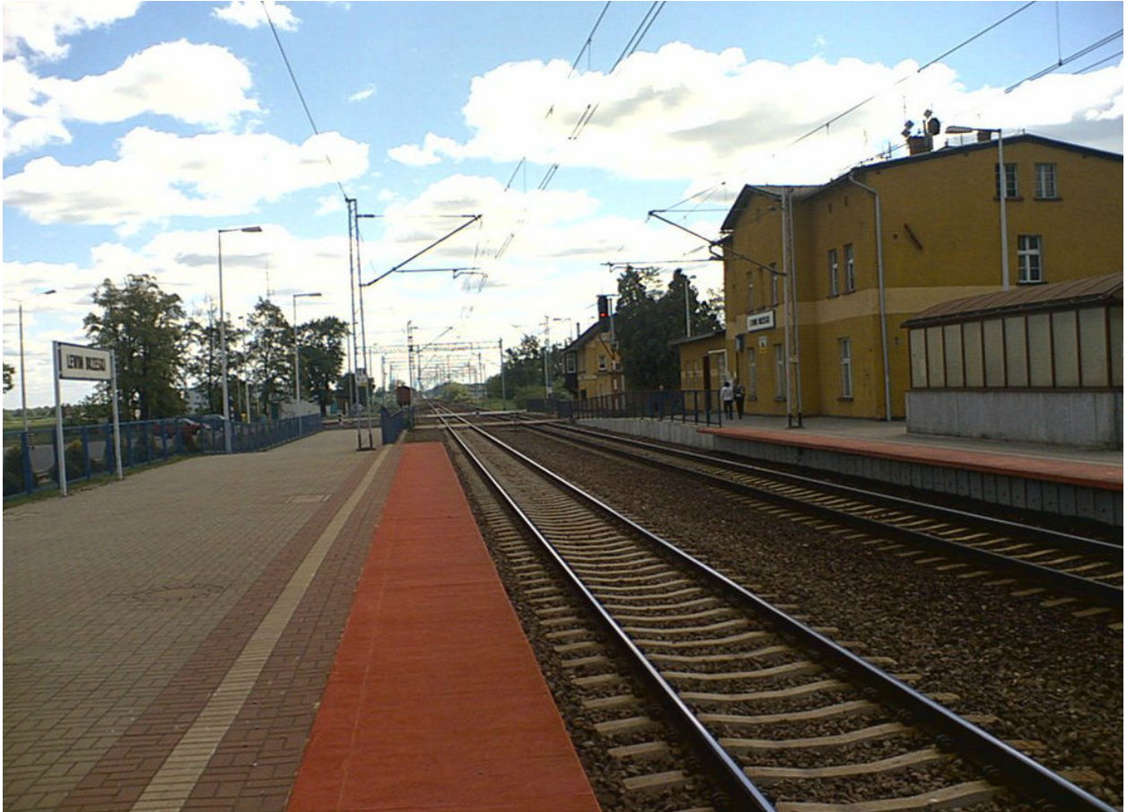
Zdjęcie 4. PKP Dworzec Kolejowy w Lewinie Brzeskim
