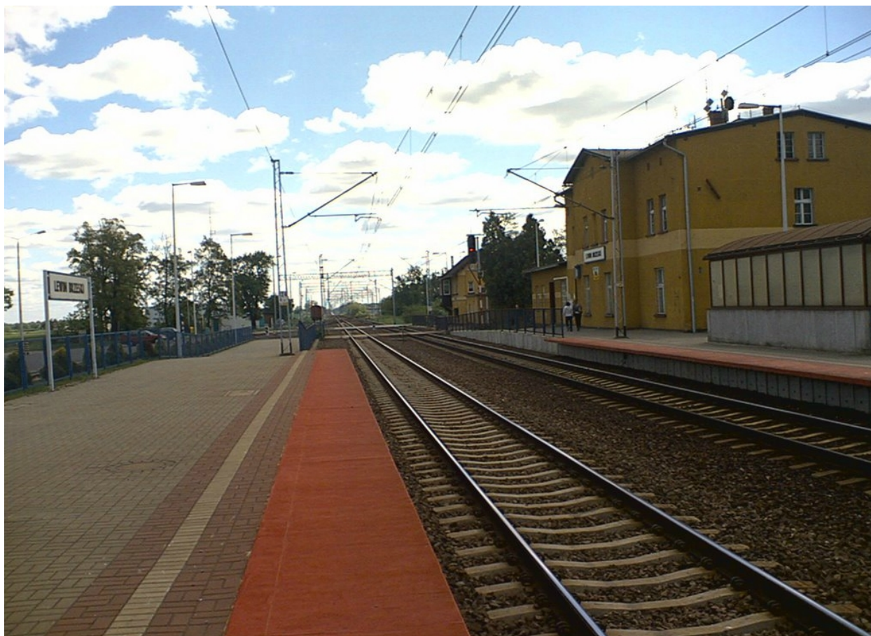
Zdjęcie 4. PKP Dworzec Kolejowy w Lewinie Brzeskim (zdjęcie załączone przez Blue Ocean Business Consulting sp. z o.o.)
