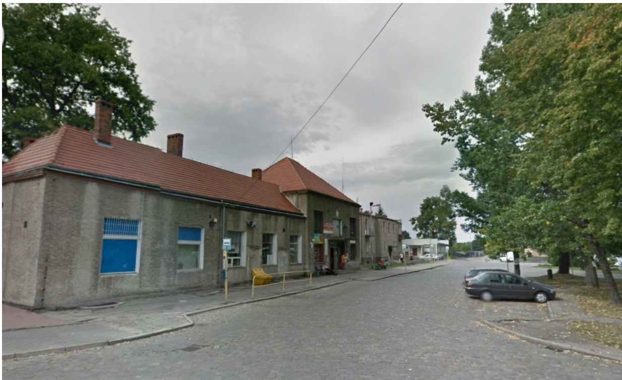
Zdjęcie 3. PKS Dworzec Autobusowy w Grodkowie (zdjęcie załączone przez Blue Ocean Business Consulting sp. z o.o.)
