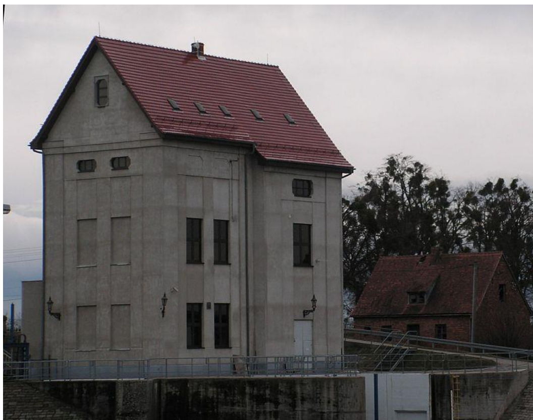
Fot. 1. OM Zwanowice EW Kopin – widok budynku z anteną linii radiowej
