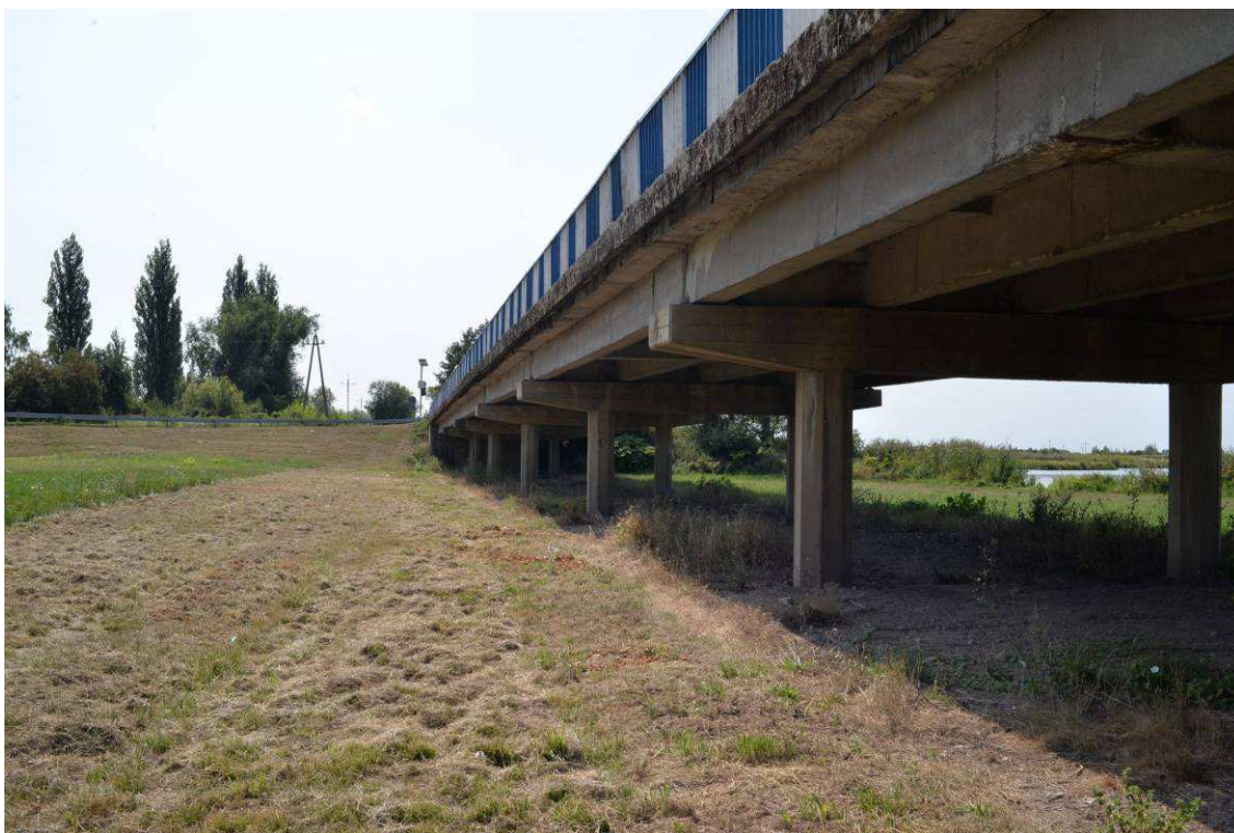
Fotografia 4 Istniejący obiekt mostowy nad zalewem rz. Nysa Kłodzka – widok na południowy przyczółek wbudowany w wał przeciwpowodziowy
