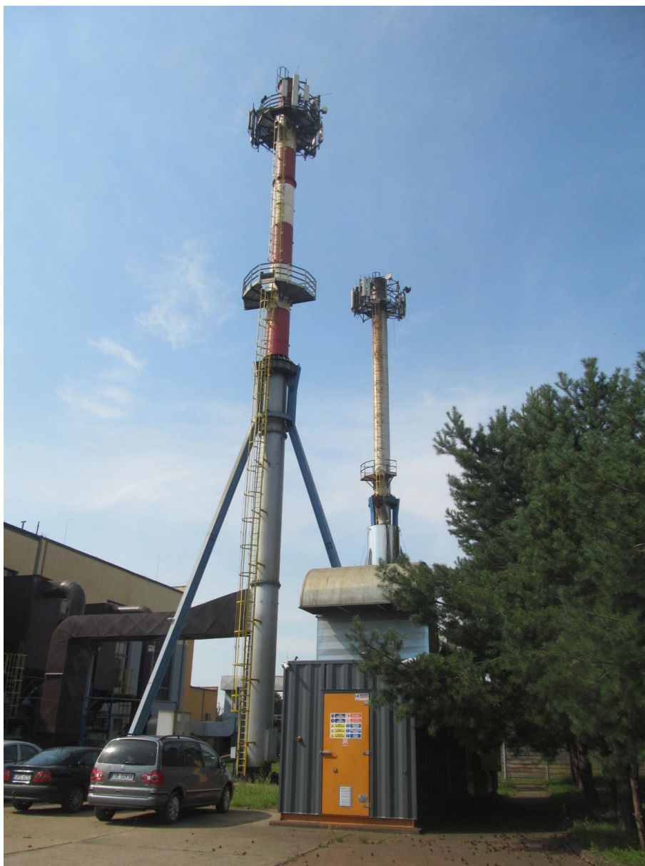
Zał. nr 1: Widok ogólny instalacji radiokomunikacyjnej.
