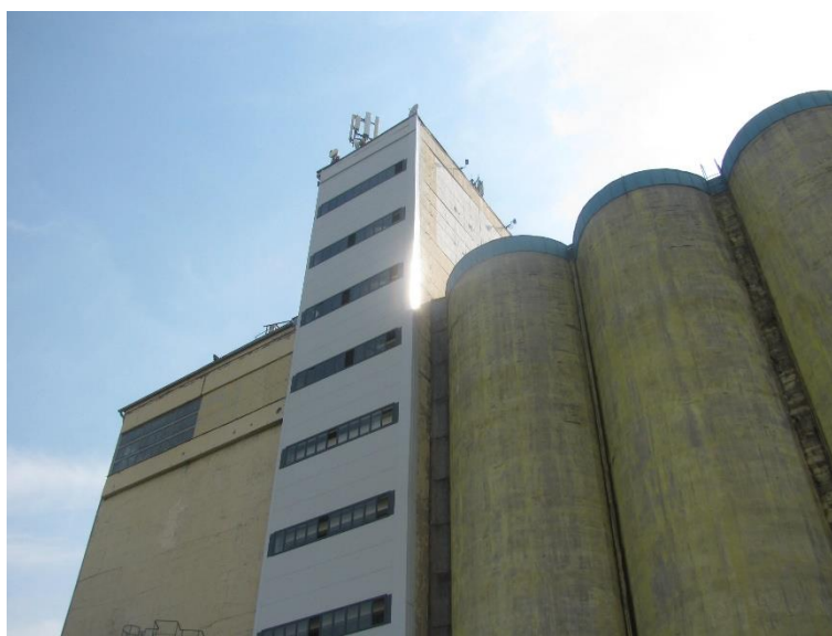
Zał. nr 1: Widok ogólny instalacji radiokomunikacyjnej.
